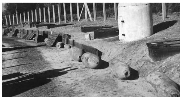
minus ging die Munition zur Zerlegung in einen Fachbetrieb nach Kiel: Das TNT wurde mit heißem Wasserdampf unter Druck ausgedüst, der Stahl eingeschmolzen und für friedliche wecke neu verwendet.
